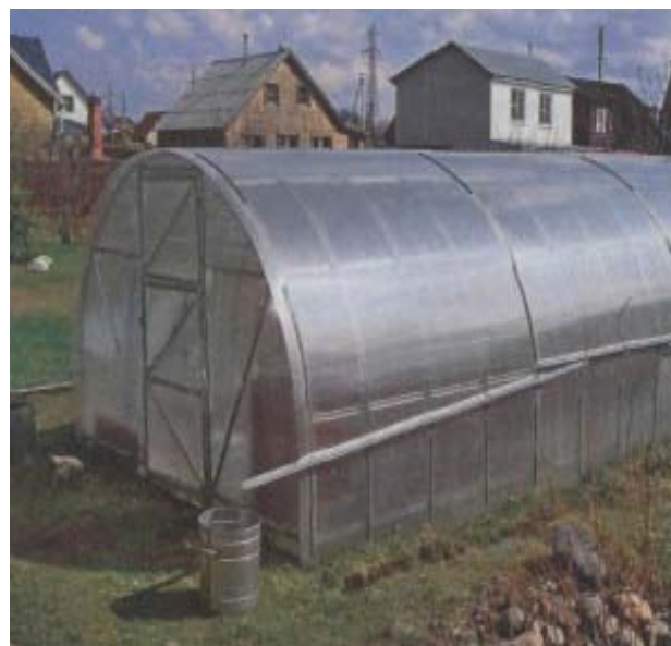
Рис. 6. Сбор дождевой воды с крыши теплицы
