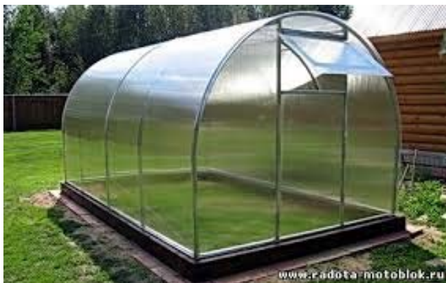
Рис. 21. Теплица без выступающей крышей из металла и поликарбоната
