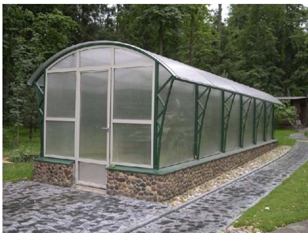
Рис. 19. Теплица с выступающей крышей из металла и поликарбоната
