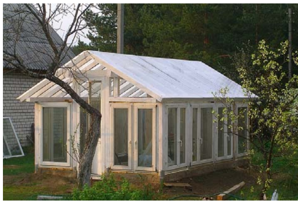
Рис. 22. Теплица с выступающей крышей из деревянных рам и стекла
