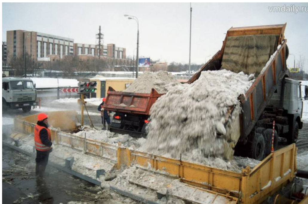
Фото 1. Снегосплавный пункт однокоридорного типа на коллекторе
